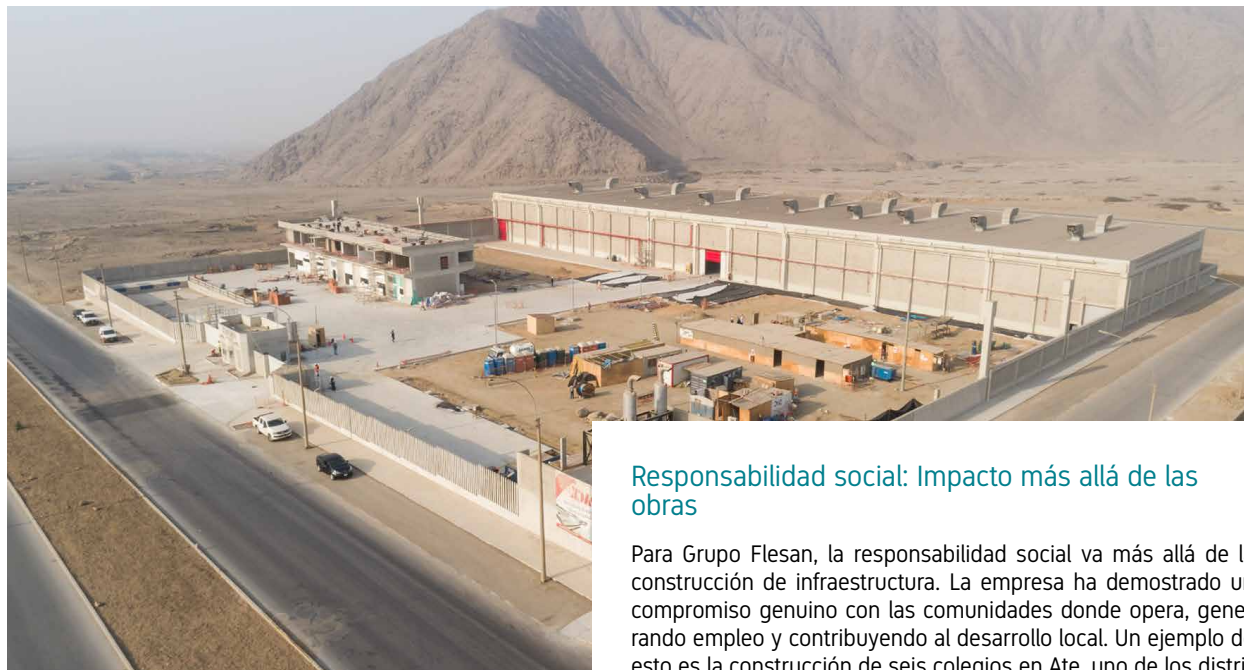
Planta de Energía Solpack.
